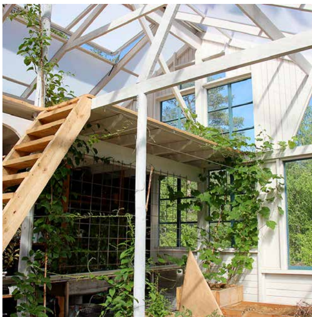
OVAN. Skogsträdgårds-växthuset. Material: återanvända fönster och glas, egensågat och återanvänt virke, begagnat tegel uppmurat med lerbruk, egenblandad linoljefärg, samt kanalplasttak. Vi murar också upp värmelagrande tegelmurar på norrsidan för att skapa en varmare miljö under kalla nätter vår och höst. På bilden syns kiwi, rankspenat, jams och vin, samt en terrass som vi byggt som social plats i växthuset.
